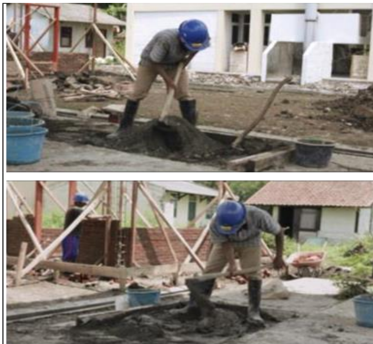
Gambar 8. Proses Pencampuran Mortar
