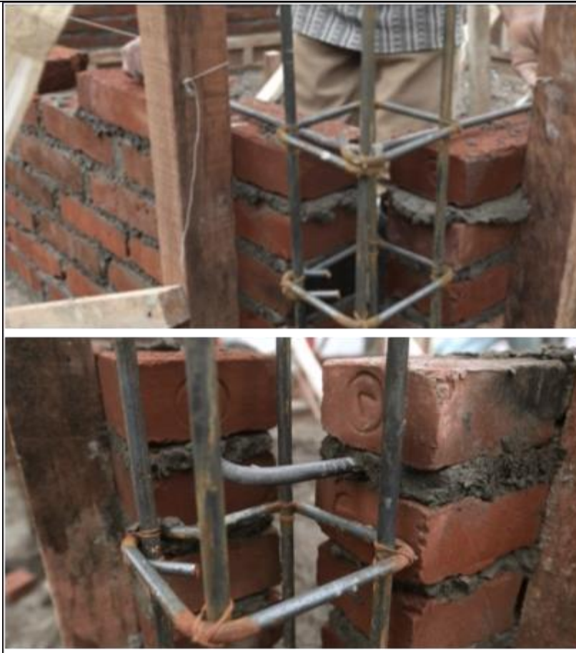
Gambar 47. Pemasangan Angkur Besi Sebagai Pengikat Antara Kolom dengan Dinding Pada Sudut Bangunan
