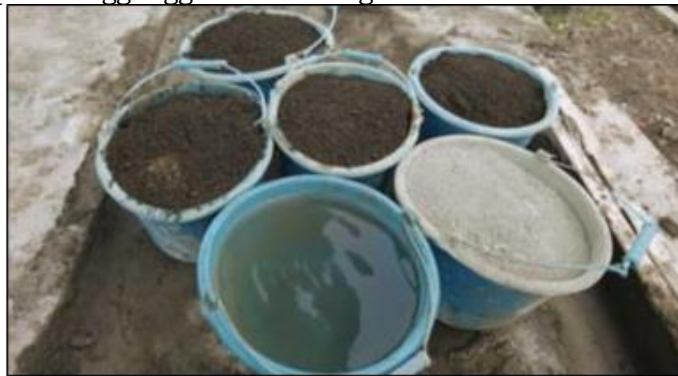
Gambar 7. Bahan Campuran Mortar
