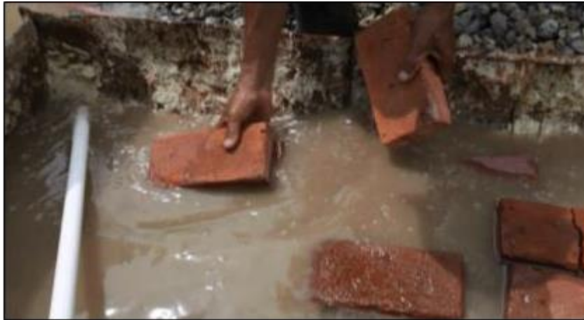
Gambar 15. Perendaman Batu Bata Sebelum Dipasang
