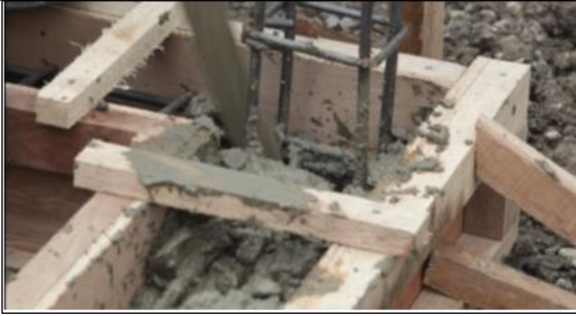
Gambar 58. Pengecoran Balok Pengikat / Sloof
