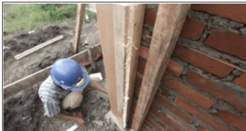
Gambar 55. Pemasangan Cetakan/ Bekisting Untuk Kolom
