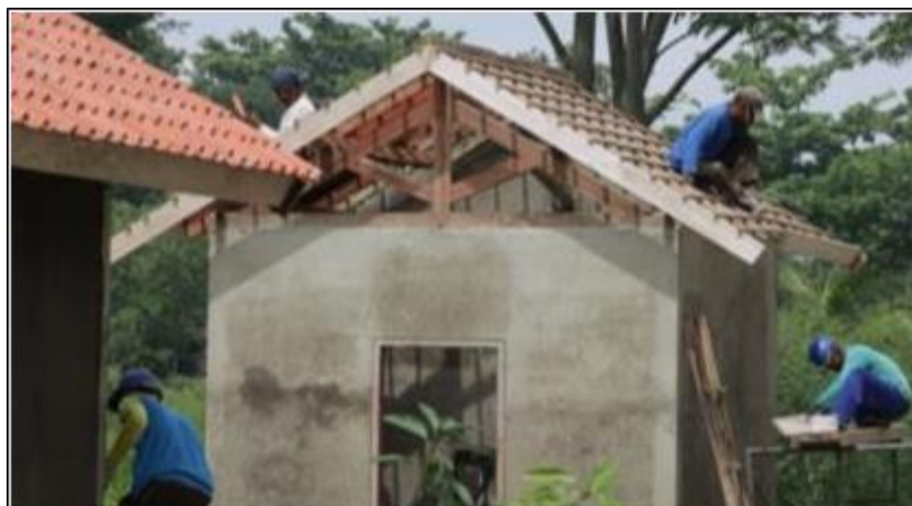
Gambar 27. Kuda-kuda Kayu Pada Atap Rumah Tinggal
