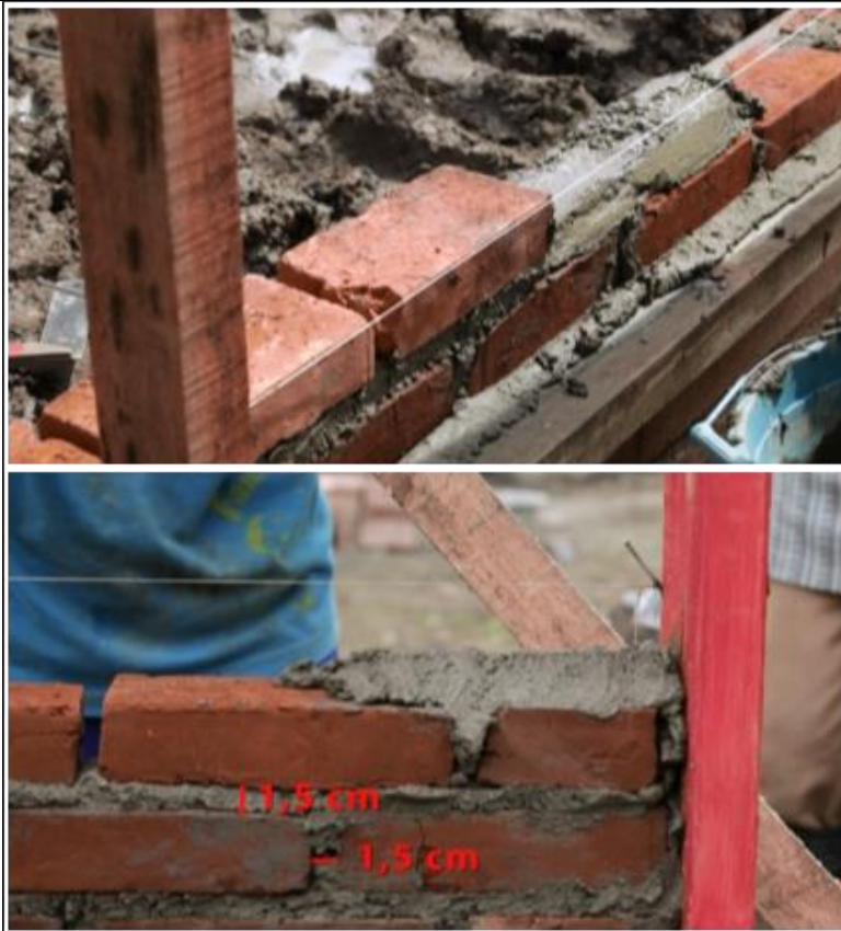
Gambar 41. Proses Pemasangan Batu Bata Untuk Dinding
