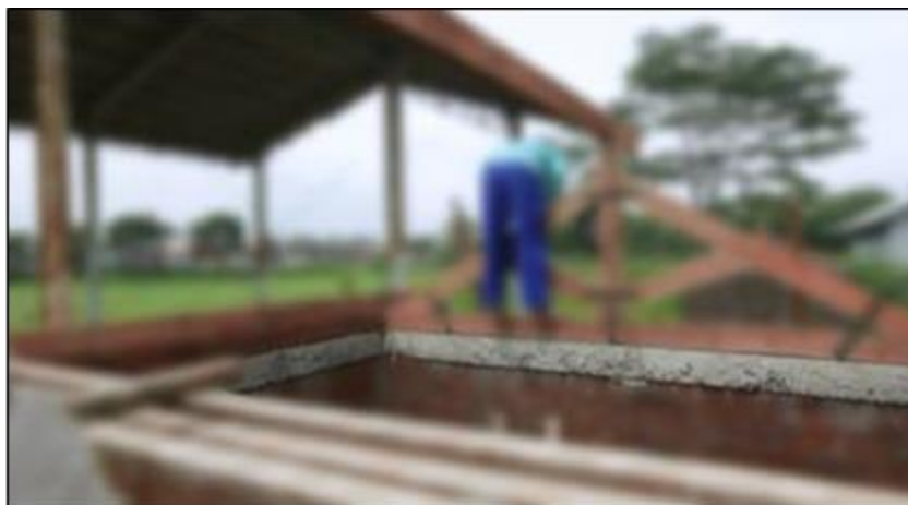
Gambar 22. Balok Keliling/ Ring
