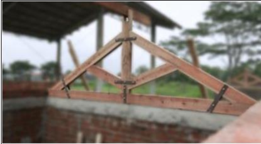
Gambar 28. Kuda-kuda Kayu Dengan Pengikat Plat Baja
