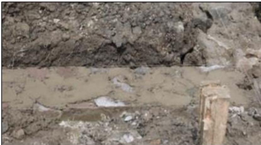
Gambar 11. Pondasi Dari Batu Kali/Gunung
