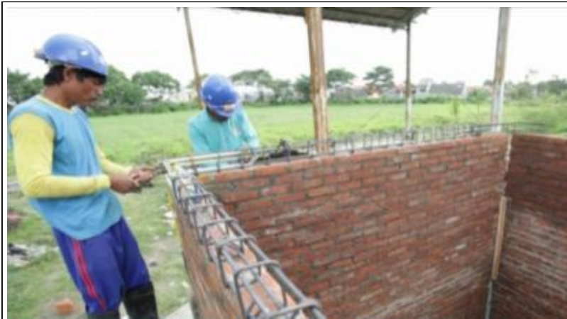
Gambar 58. Pengecoran Balok Pengikat / Sloof
