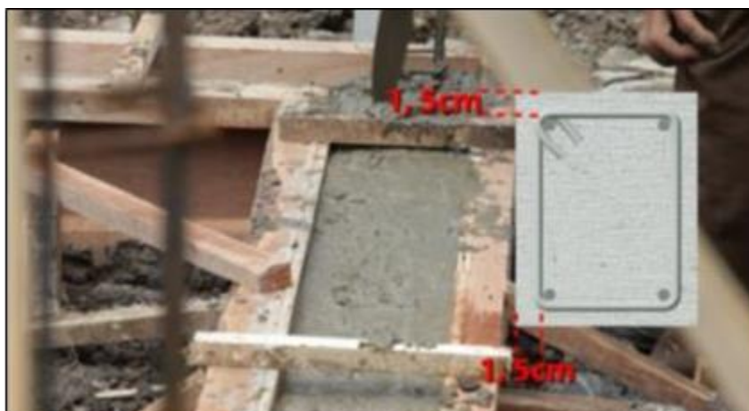
Gambar 19. Balok Pengikat/ Sloof
