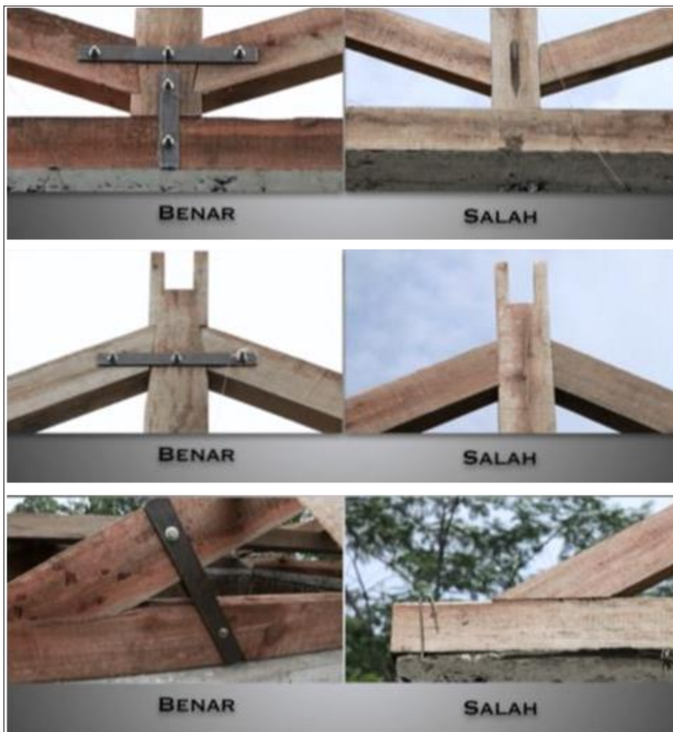
Gambar 29. Pemasangan Plat Baja Pada Kuda-kuda Kayu
