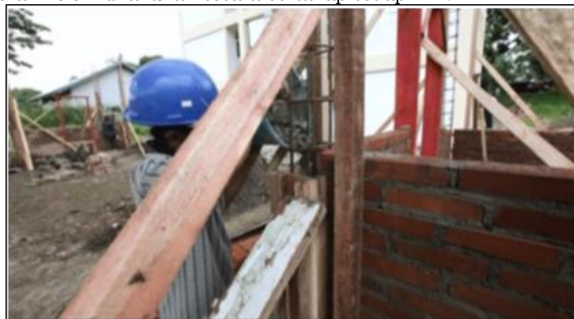
Gambar 56. Proses Pengecoran Kolom
