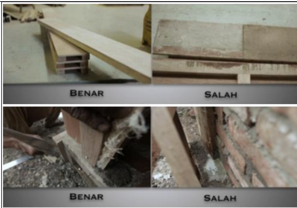
Gambar 54. Kualitas Cetakan/ Bekisting
