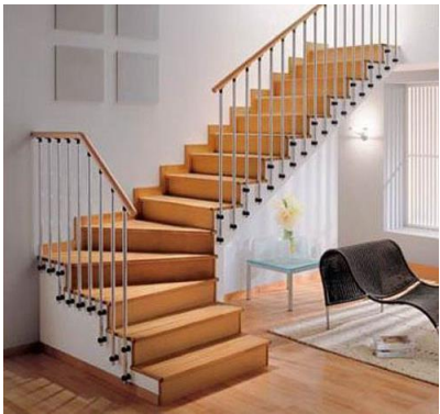
Gambar 2.53. Contoh penerapan tangga kipas
