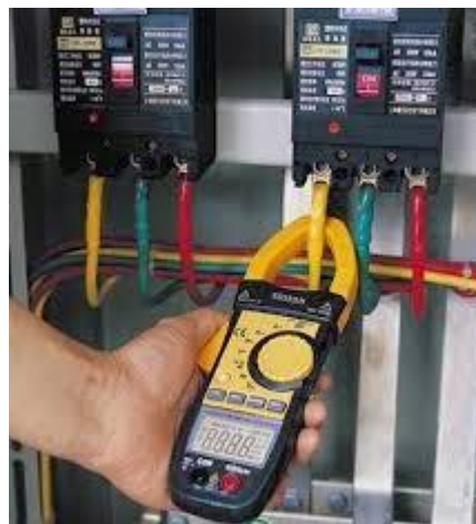
Gambar.E.8. Ilustrasi Pemeriksaan menggunakan Clamp Meter
