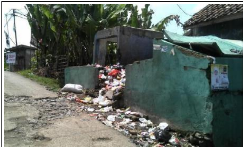
Gambar 13. Contoh sistem pengangkutan sampah yang tidak berjalan baik sehingga terjadi penumpukan sampah di TPS
