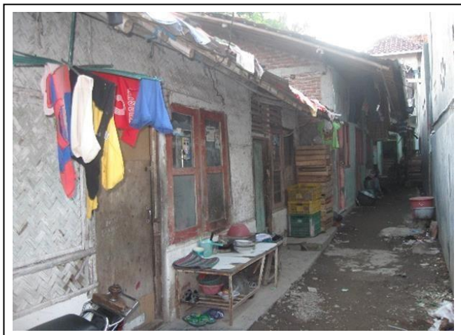
Gambar 6. Contoh kondisi jalan yang tidak dilengkapi saluran drainase
