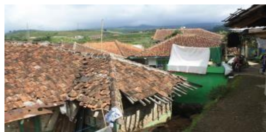
Tipologi Perumahan/Permukiman Kumuh di Perbukitan
