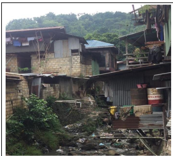
Gambar 3. Contoh Kondisi Bangunan yang tidak sehat
