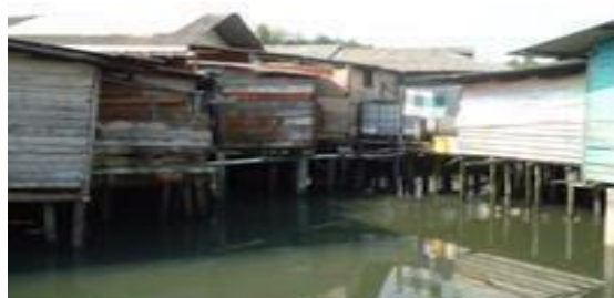
Tipologi Perumahan / Permukiman Kumuh di Atas Air
