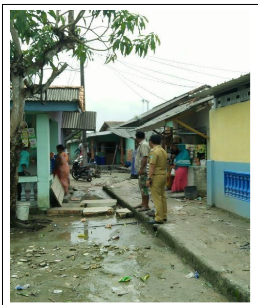
Gambar 4. Contoh kondisi perumahan yang tidak melayani jalan lingkungan
