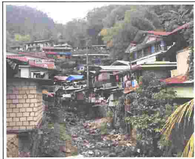
Gambar 1. Contoh Kondisi Ketidakteraturan Bangunan
