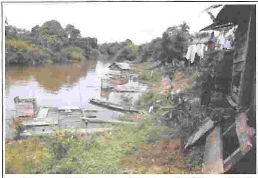
Gambar 10. Contoh Sistem Pengolahan Air Limbah Setempat yang Tidak Sesuai Standar (Sumber: Peraturan Menteri Pekerjaan Umum Nomor: 14/PRT/M/2018)
