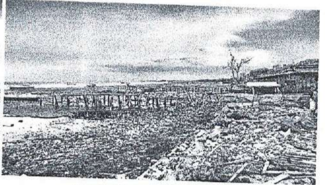
Kondisi Rawan Abrasi Pantai
