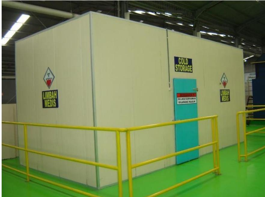
Gambar 2. Contoh ruang pendingin untuk penyimpanan Limbah berupa Limbah infeksius, benda tajam, dan/atau patologis dalam waktu lebih dari 48 (empat puluh delapan) jam sejak Limbah dihasilkan.
