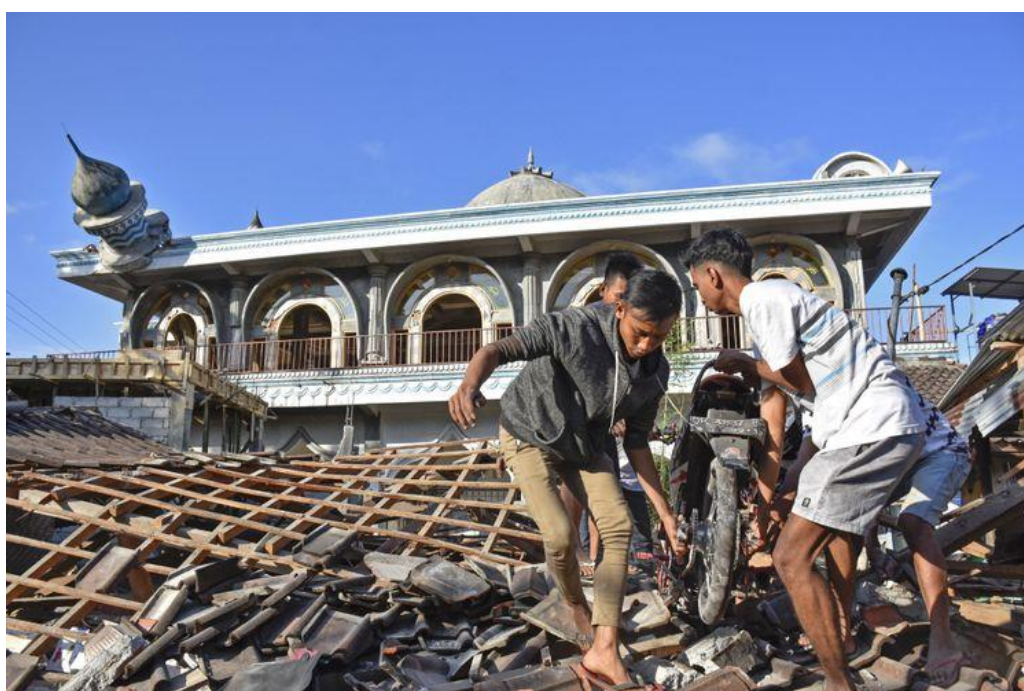
Gambar 2.9. Dampak akibat Gempa Lombok 2018 di salah satu wilayah di Kabupaten Lombok Utara (Sumber: Kompas, 2018)
