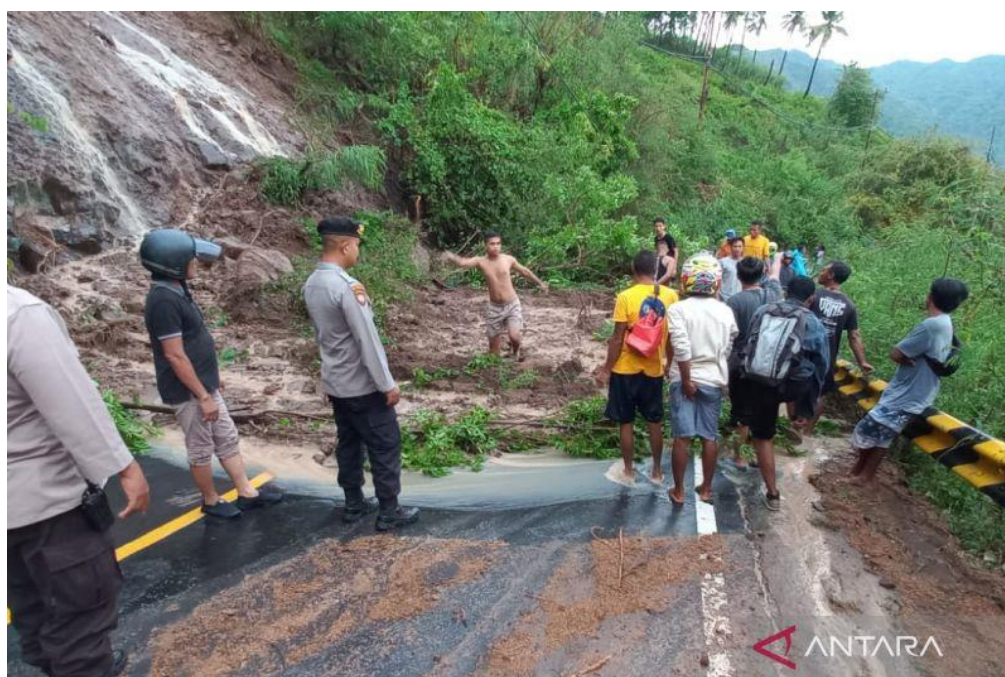
Gambar 2.11. Kondisi jalan di Desa Malaka yang terpapar longsor pada 17 Oktober 2022 (Sumber: Antara, 2022)
