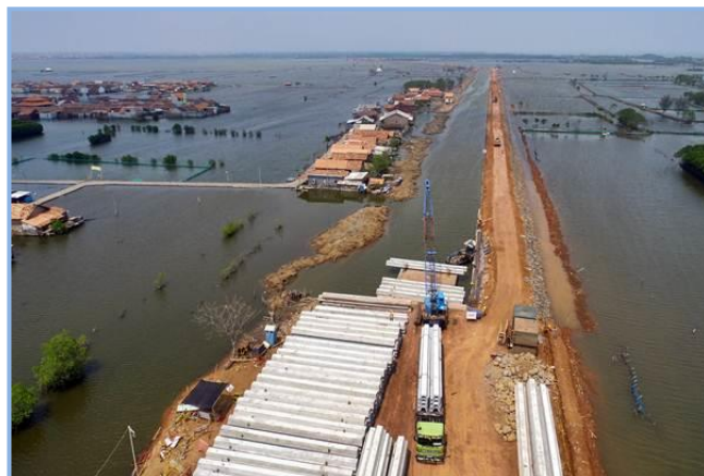
Gambar 2.106 Pembangunan Tanggul Pengendalian Banjir dan Rob Pekalongan
