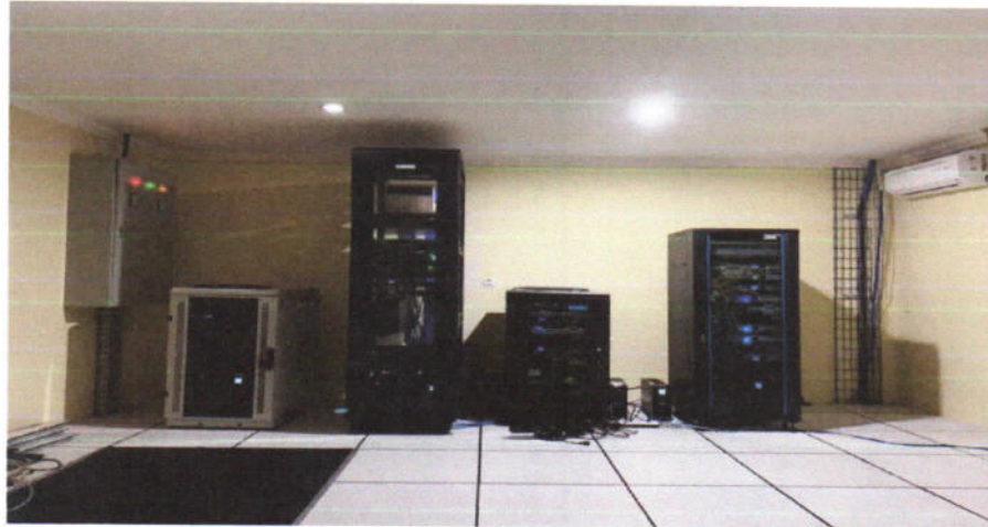
Gambar IV.2 Kondisi Eksisting Data Center Pemerintah Kabupaten Rembang
