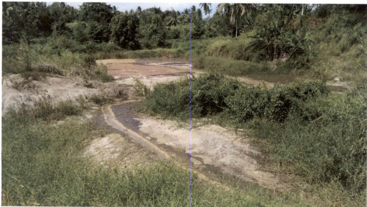
Gambar 19. Kolam tempat penampungan limbah/tailing di Desa Tanoyan Kab. Bolaang Mongondow
