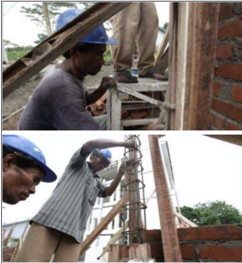
Gambar 57. Pemasangan dan Pemasukan Beton Dengan Memukul-mukul Cetakan/ Bekisting dan Campuran Beton Dirojok Menggunakan Besi atau Bambu
