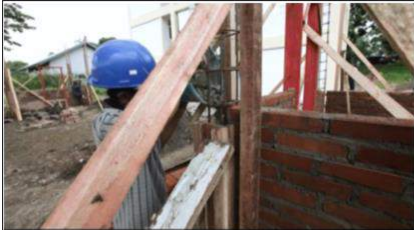
Gambar 5. Proses Pengecoran Kolom
