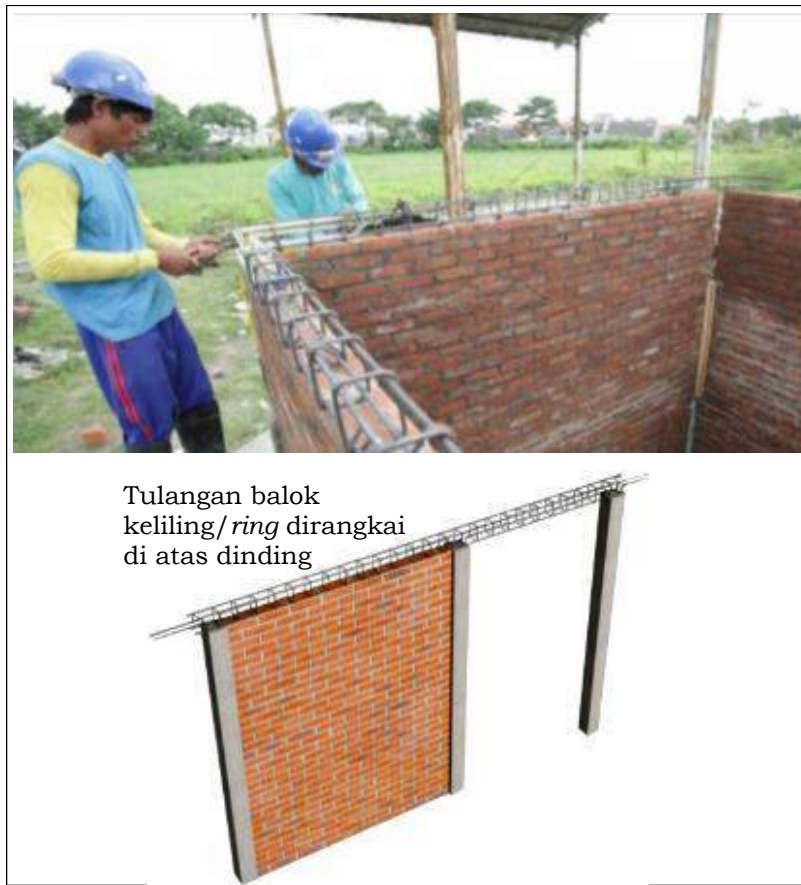
Gambar 59. Perangkaian Tulangan Balok Keliling/ Ring Di Atas Dinding
