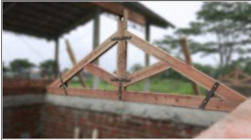
Gambar 28. Kuda-kuda Kayu Dengan Pengikat Plat Baja
