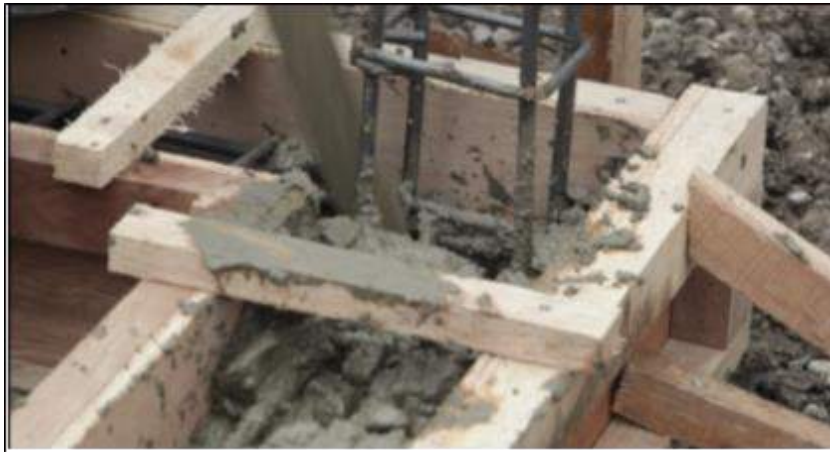
Gambar 58. Pengecoran Balok Pengikat/ Sloof
