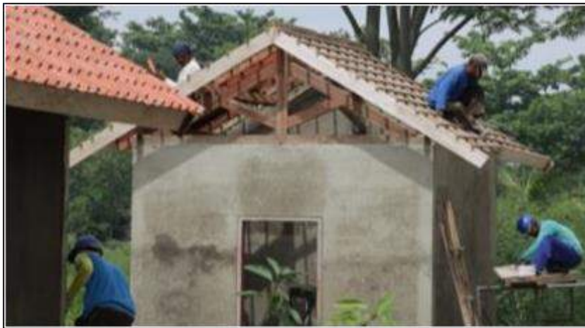
Gambar 27. Kuda-kuda Kayu Pada Atap Rumah Tinggal
