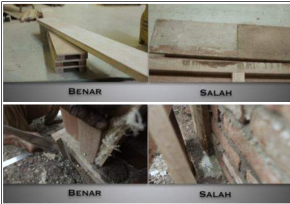
Gambar 54. Kualitas Cetakan/ Bekisting
