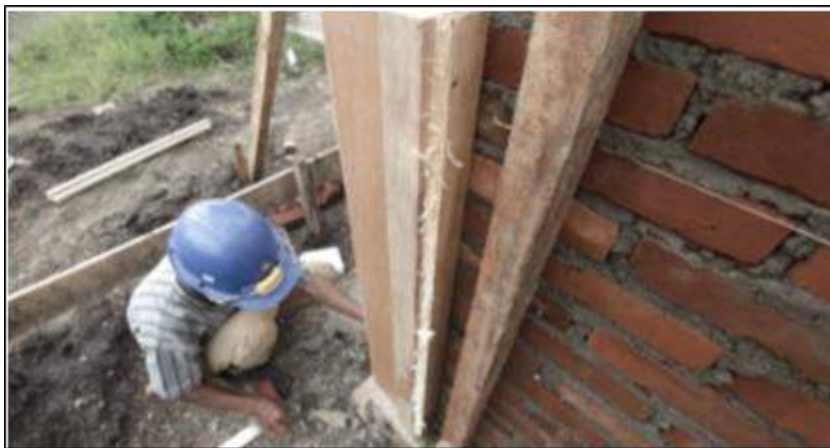
Gambar 55. Pemasangan Cetakan/ Bekisting Untuk Kolom
