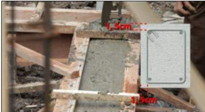
Gambar 19. Balok Pengikat/ Sloof
