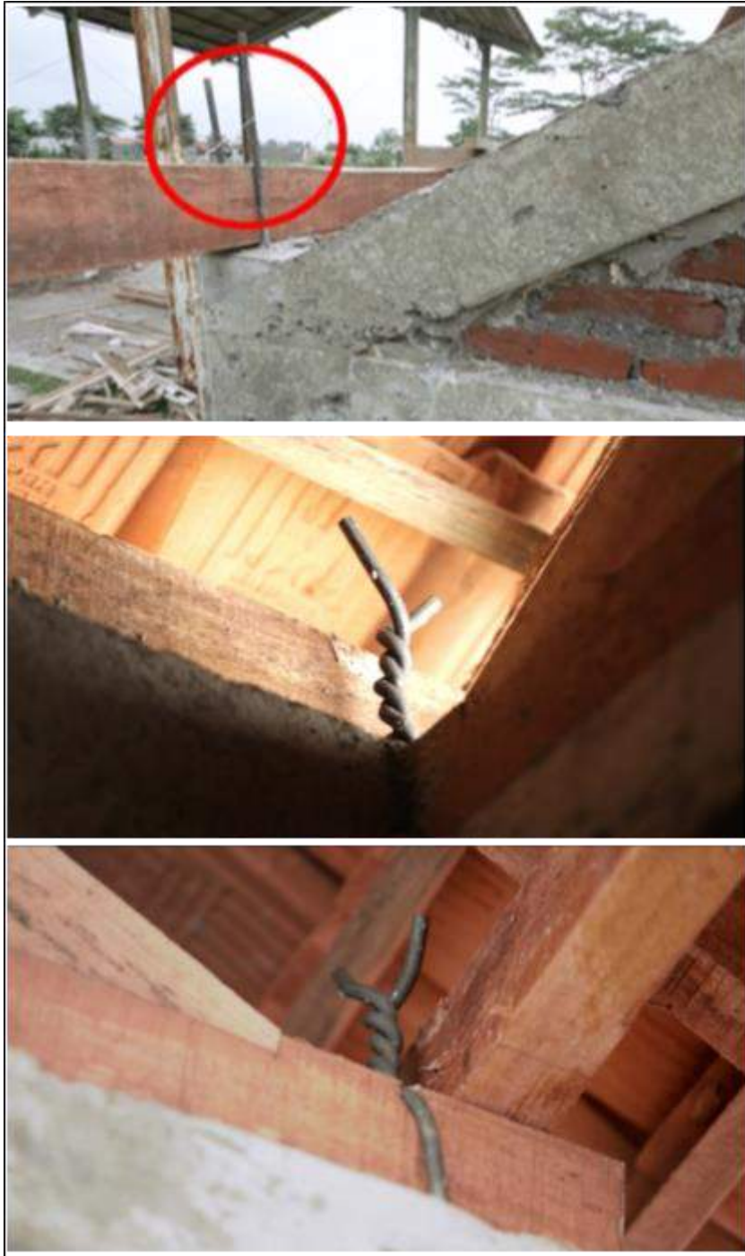
Gambar 51. Pengikatan Kuda-Kuda Kayu Pada Balok Keliling/ Ring Menggunakan Angkur
