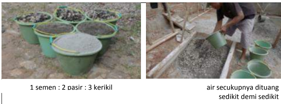
Gambar 2. Pencampuran Beton
