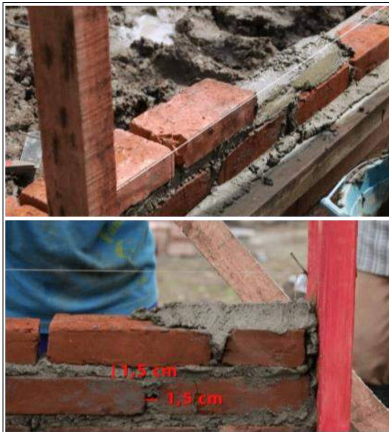
Gambar 41. Proses Pemasangan Batu Bata Untuk Dinding
