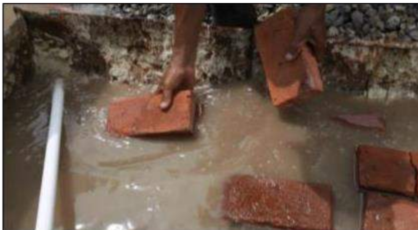
Gambar 15. Perendaman Batu Bata Sebelum Dipasang
