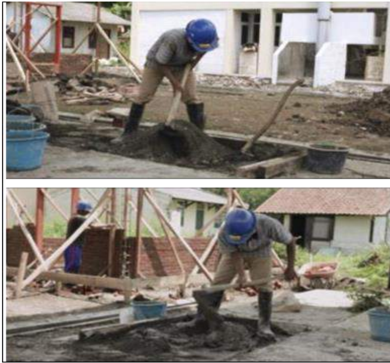
Gambar 8. Proses Pencampuran Mortar
