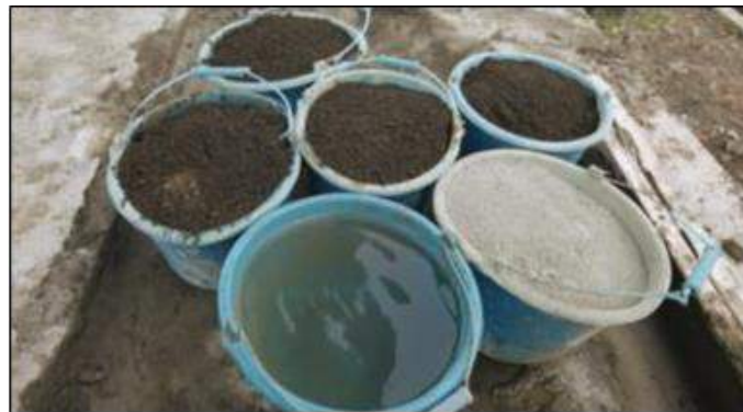
Gambar 7. Bahan Campuran Mortar
