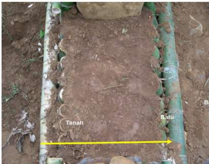
Gambar 4.44. Bio Gully Plug tampak Atas di lapangan
