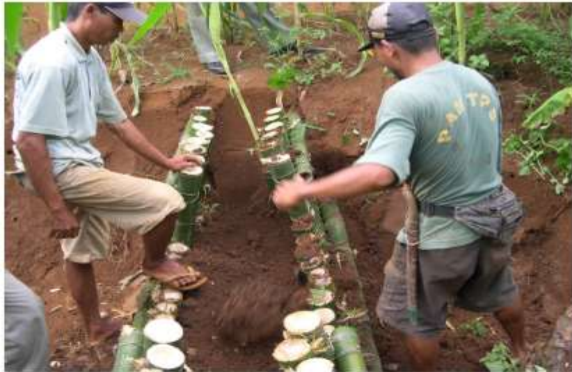
Gambar 4.43. Proses pembuatan Bio Gully Plug
