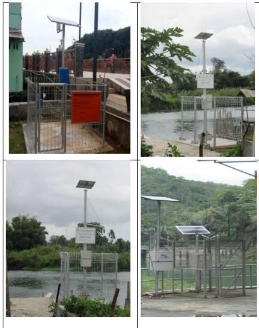
Gambar 6. Contoh Bangunan Pelindung Tidak Permanen
