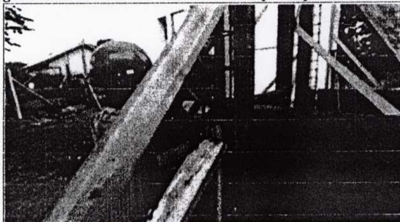
Gambar 56. Proses Pengecoran Kolom
