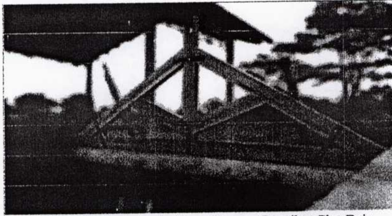
Gambar 28. Kuda-kuda Kayu Dengan Pengikat Plat Baja
