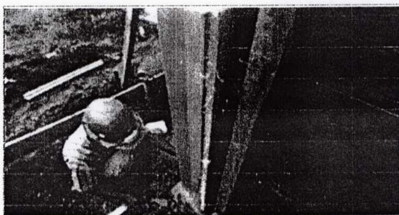
Gambar 55. Pemasangan Cetakan / Bekisting Untuk Kolom
