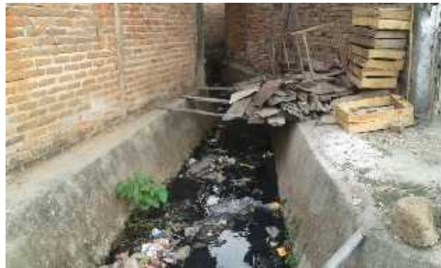
Gambar 2.8 Saluran Drainase di Talang Jawa
