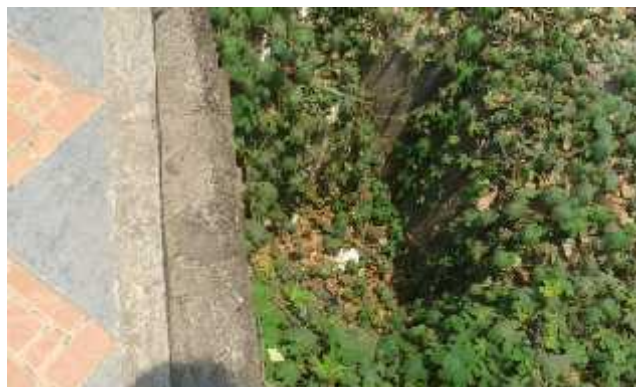
Gambar 2.13 Saluran Drainase di Wilayah GOR Kolam Renang Lintas
