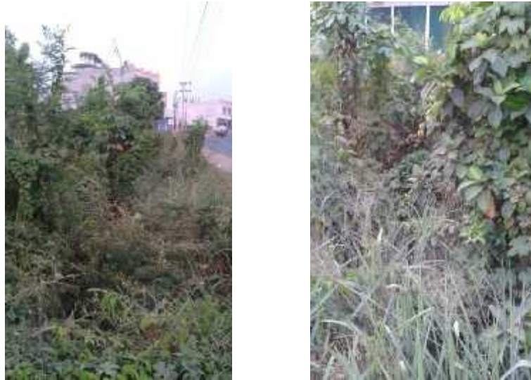
Gambar 2.10 Saluran Drainase di Jalan SPBU Batu Kuning
