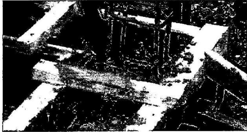
Gambar 58. Pengecoran Balok Pengikat/ Sloof
