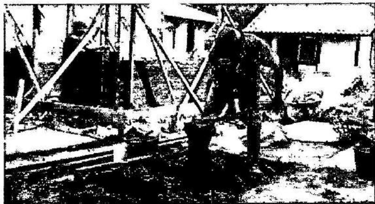
Gambar 8. Proses Pencampuran Mortar
