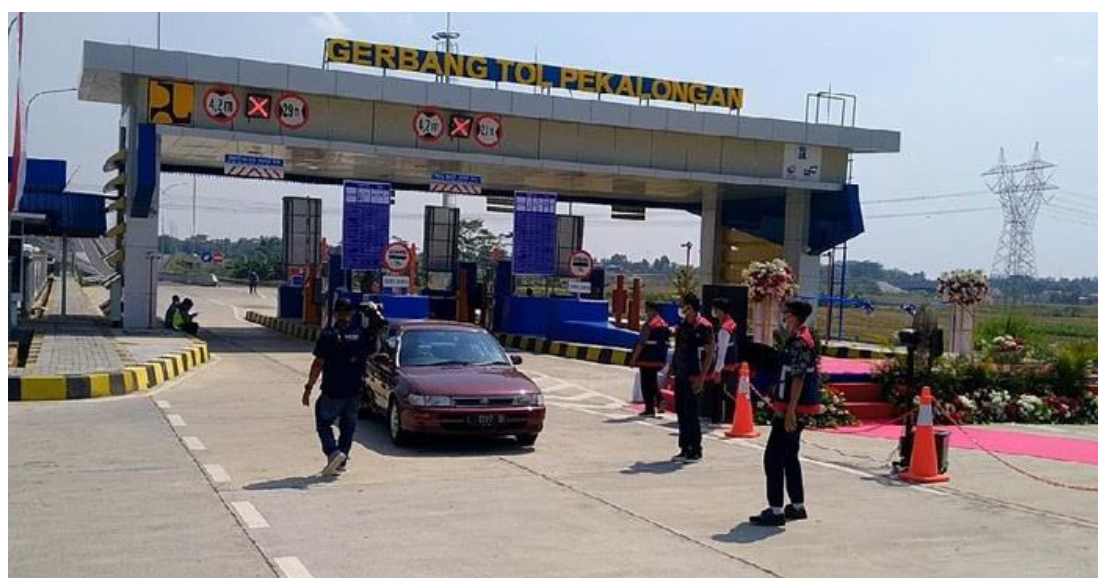
Gambar 2.73. Exit Tol Bojong Kabupaten Pekalongan Pekalongan
