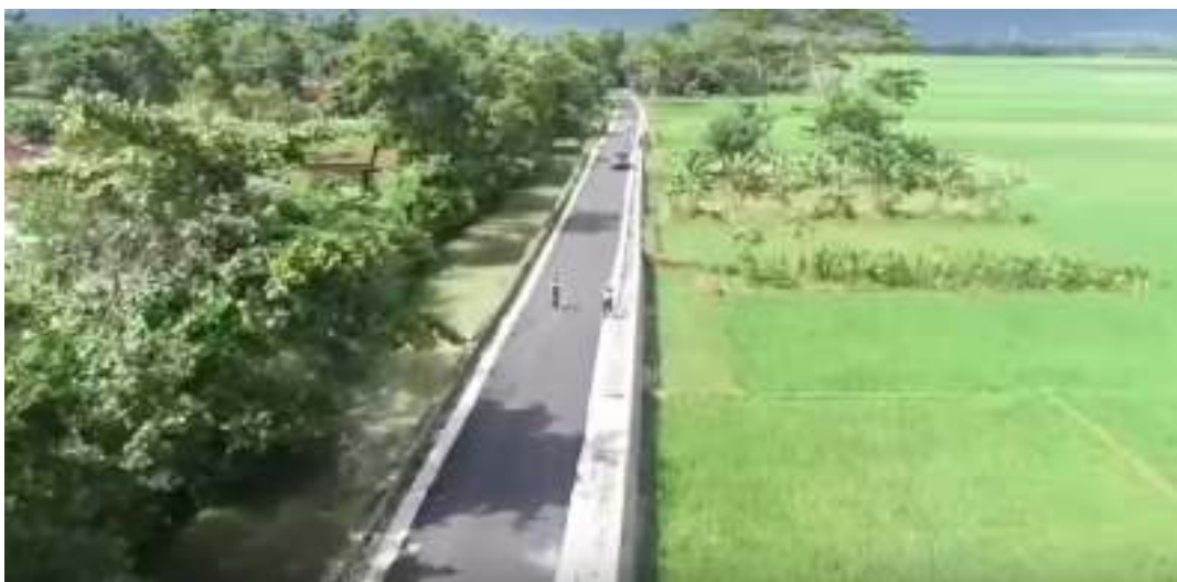
Gambar 4. 16 Jalan dengan Aspal Hotmix Campuran Limbah Plastik
