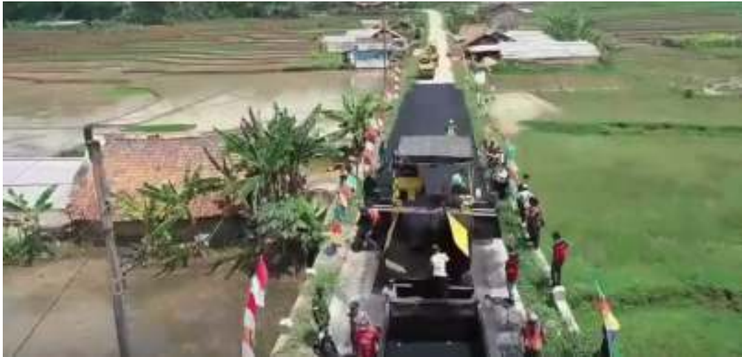
Gambar 4. 15 Pemanfaatan Limbah Plastik untuk Aspal Hotmix
