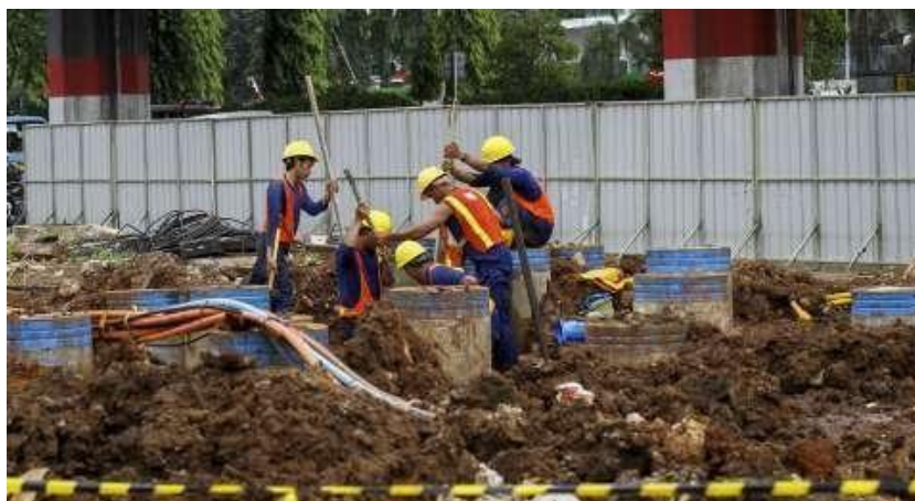
Gambar 8. 4. Penggantian Pipa Transmisi
