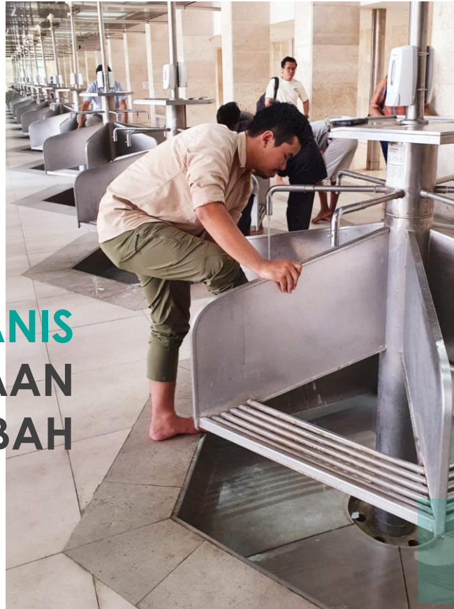
Instalasi Pengolahan Air Wudlu Masjid Istiqlal, Jakarta Foto Setditjen PPKL
