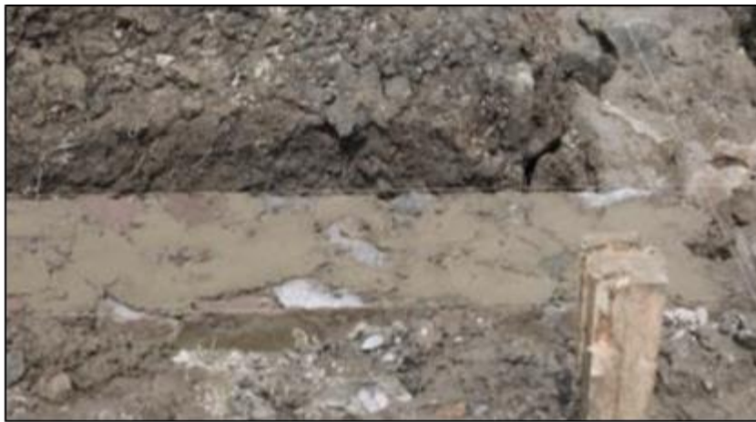
Gambar 11. Pondasi Dari Batu Kali/Gunung
