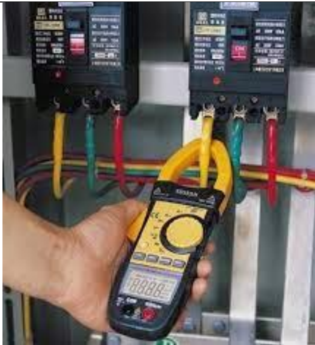
Ilustrasi Pemeriksaan menggunakan Clamp Meter
