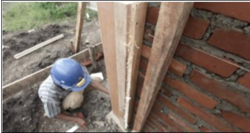
Gambar 55. Pemasangan Cetakan/ Bekisting Untuk Kolom
