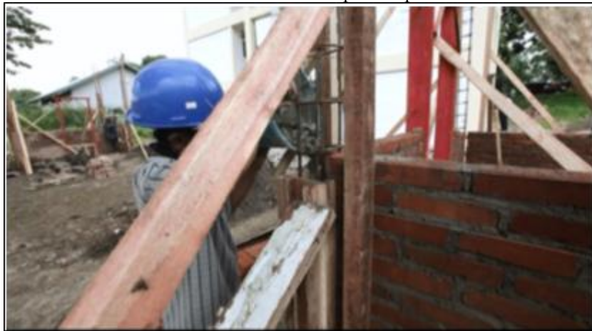
Gambar 56. Proses Pengecoran Kolom
