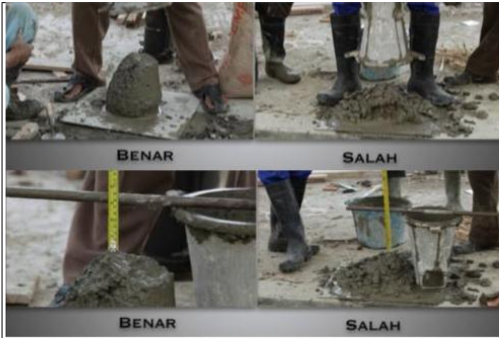
Gambar 4. Pengujian Sederhana Dengan Menggunakan Cetakan dan Mengukur Selisih Ketinggian dengan Cetakan
