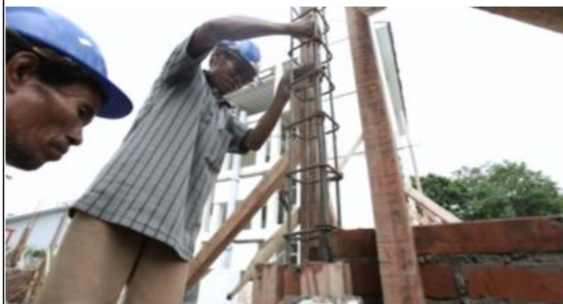
Gambar 57. Pemasangan Besi dan Campuran Beton Pemasangan Besi dan Campuran Beton
