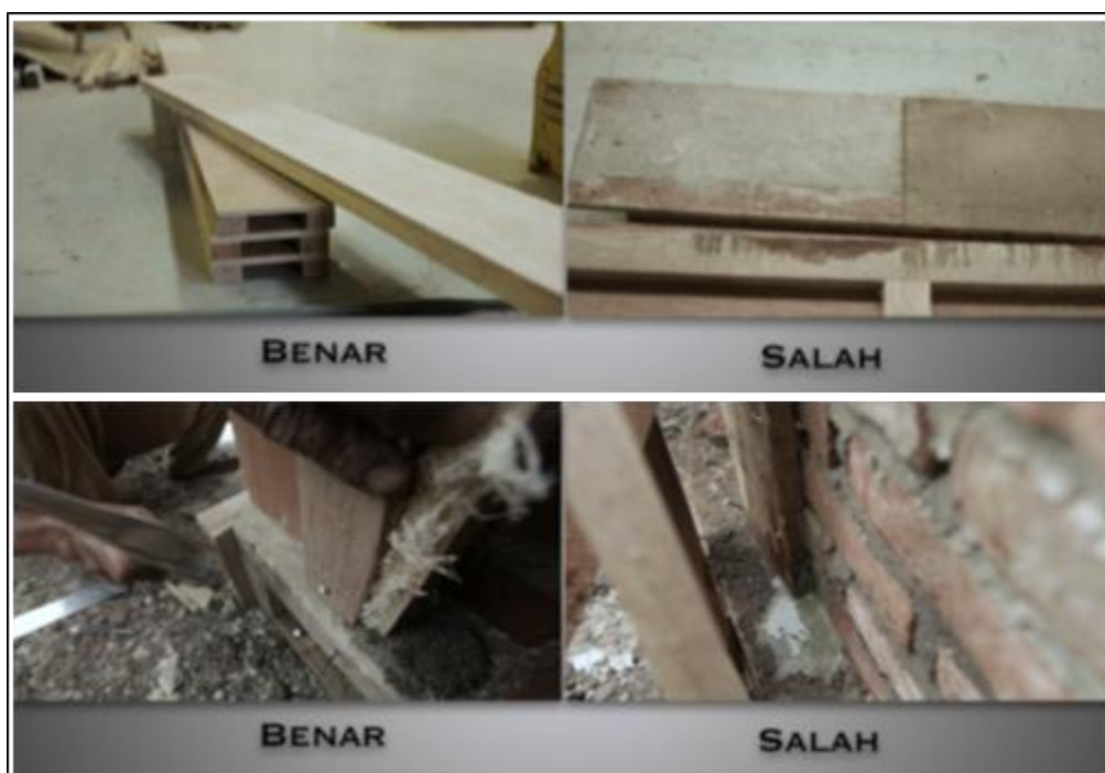
Gambar 54. Kualitas Cetakan/ Bekisting
