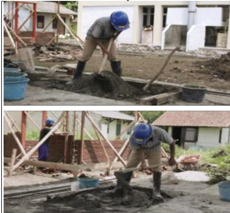
Gambar 8. Proses Pencampuran Mortar
