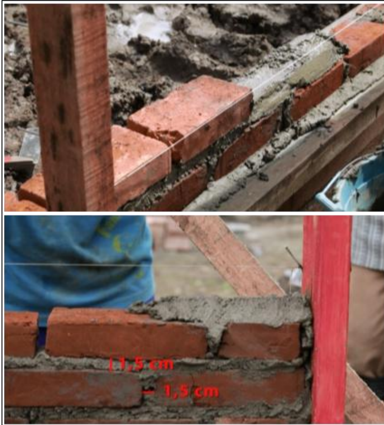
Gambar 41. Proses Pemasangan Batu Bata Untuk Dinding
