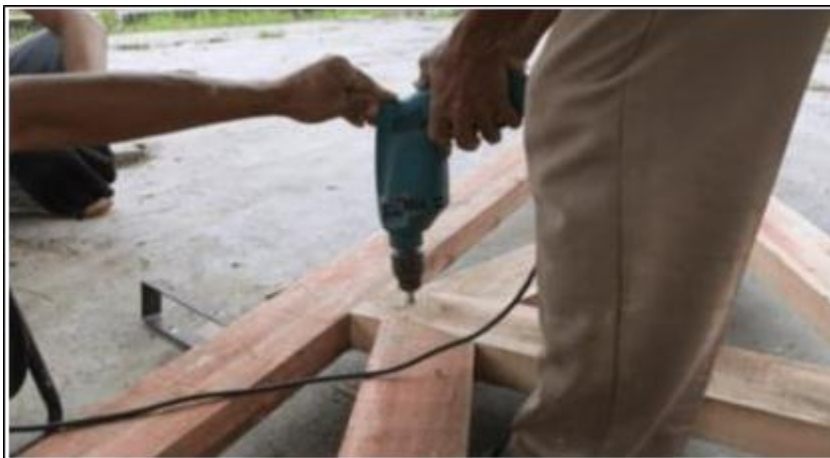
Gambar 31. Pemasangan Plat Baja Pada Kuda-Kuda Kayu Menggunakan Bor Listrik
