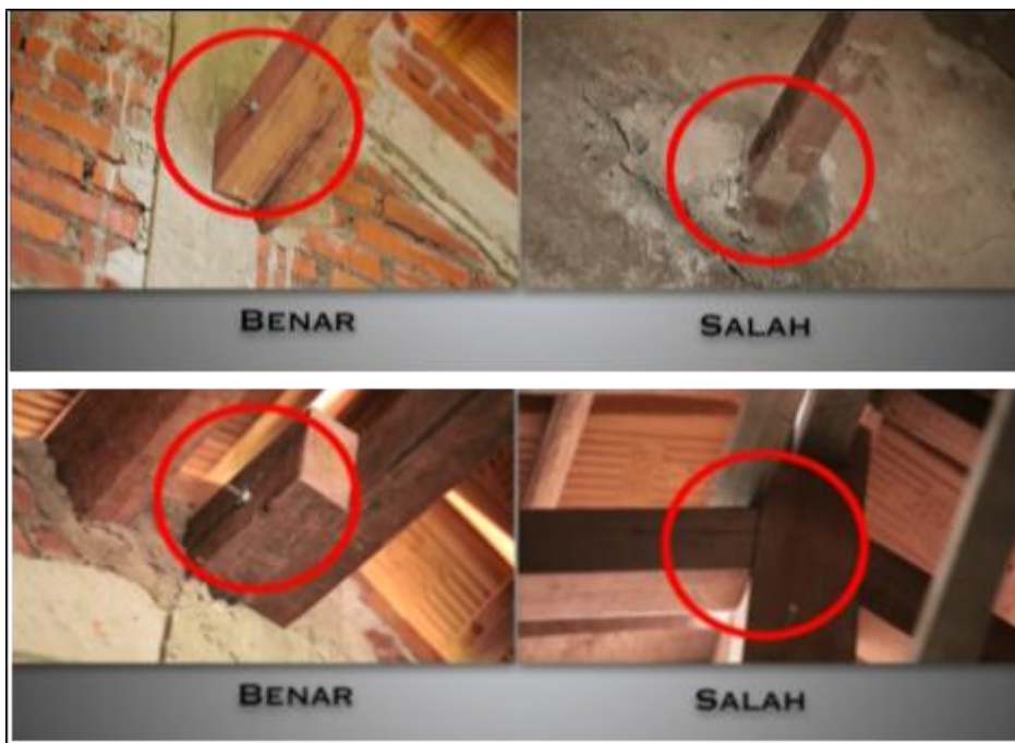
Gambar 38. Detail Pertemuan Antara Ikatan Angin dengan Gunung-Gunung/ Ampig
