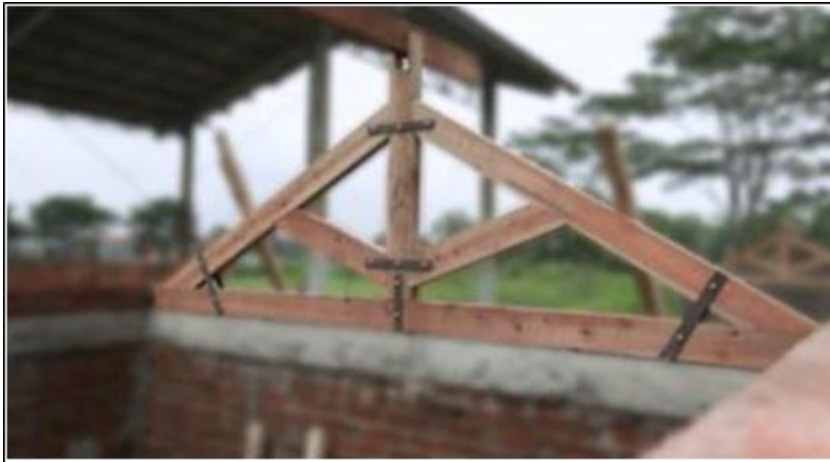
Gambar 28. Kuda-kuda Kayu Dengan Pengikat Plat Baja
