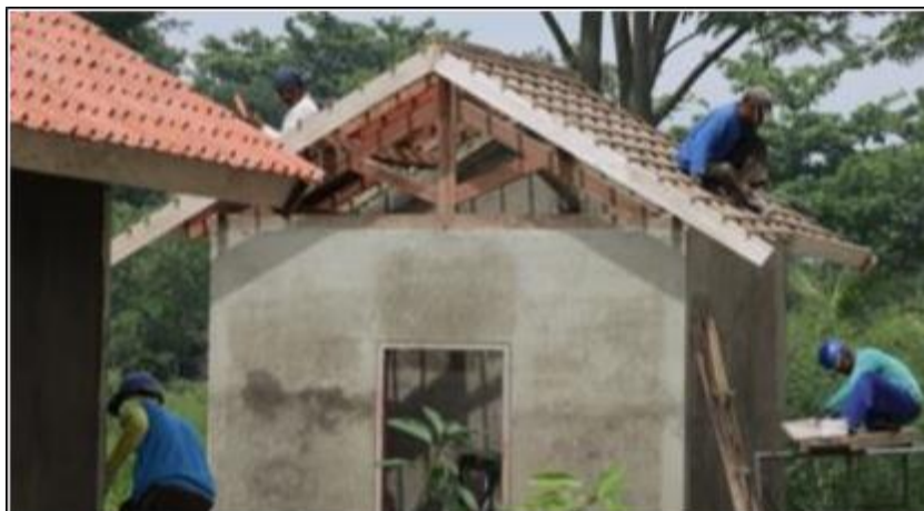
Gambar 26. Detail Kuda-Kuda Kayu
