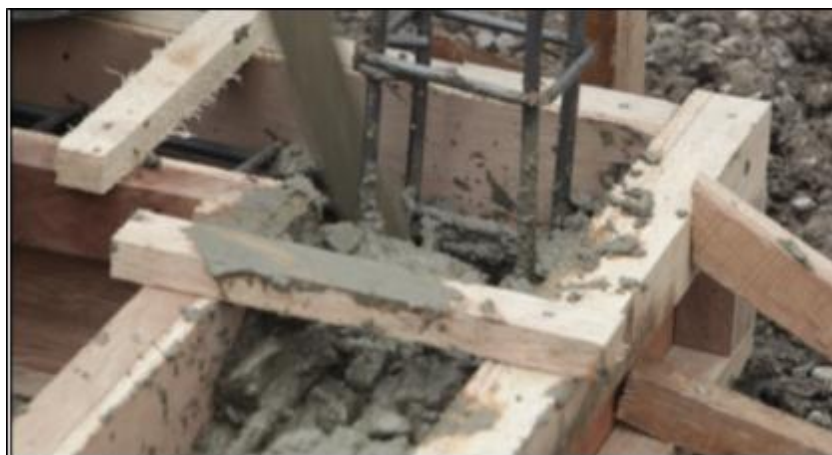
Gambar 58. Pengecoran Balok Pengikat/ Sloof
