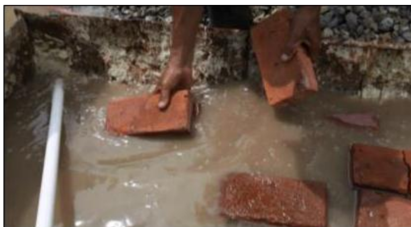
Gambar 15. Perendaman Batu Bata Sebelum Dipasang
