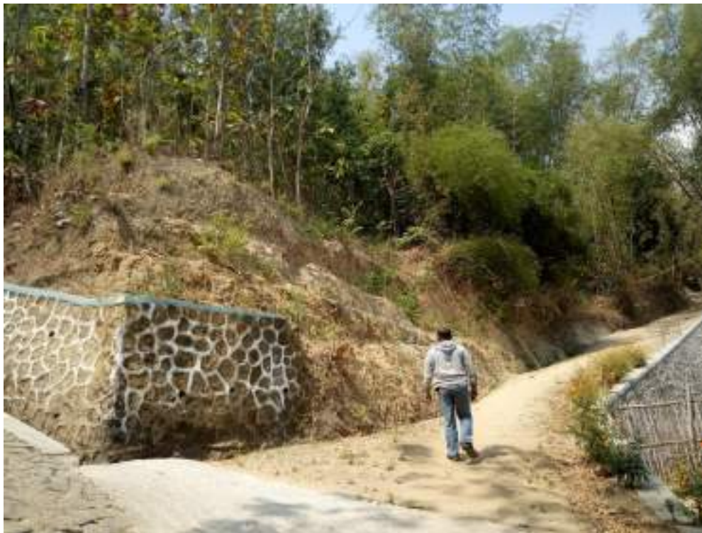
Gambar.2.52 Pembuatan talud pada lereng bukit untuk mengurangi resiko terjadinya gerakan tanah
