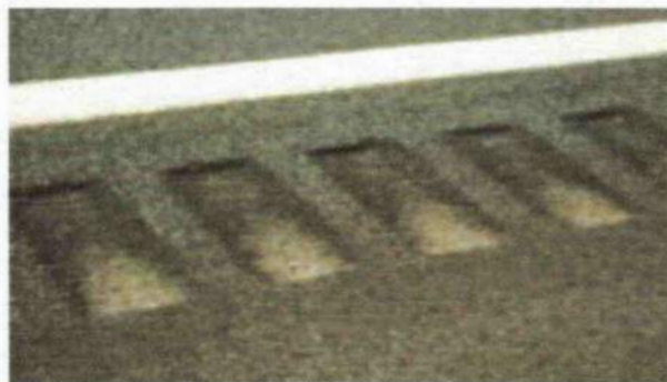
Gambar 61 Pemasangan Shoulder Rumble
