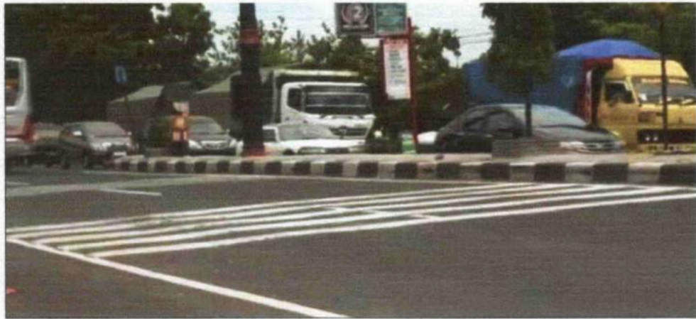
Gambar 60 Pemasangan Rumble Strip
