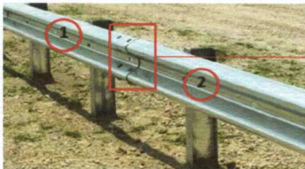
Gambar 13 Metode Penyambungan Beam Tampak Samping
