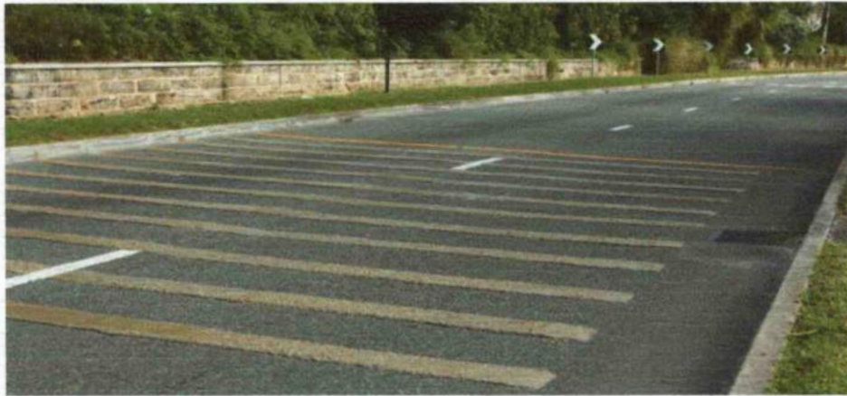
Gambar 62 Pemasangan Rumble Area
