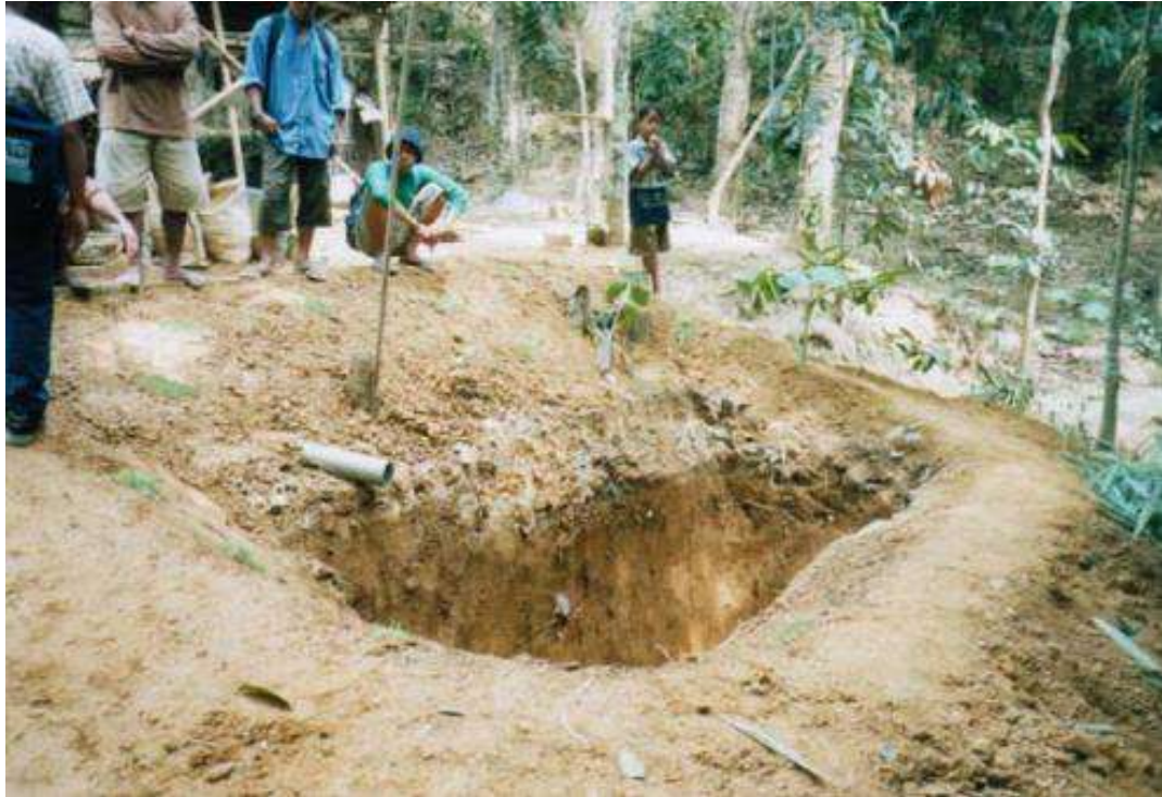
Gambar 2.8. Kolam Penampungan Tailing
