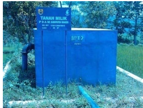
Gambar 3.14 Bak Pelepas
