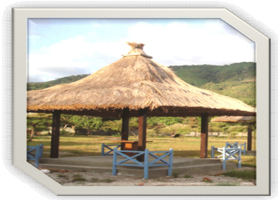
Gambar 16. Contoh Bangunan Shelter
