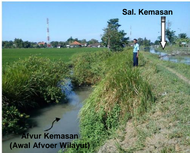
Foto 1 : Awal terlihat aliran afvoer, perbedaan elevasi yang cukup tinggi antara muka air Afvoer dan Saluran Kemasan
