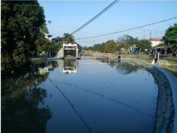
Foto 3 : Afvoer Wilayut, menjadi saluran besar yang juga membagi air untuk irigasi sawah di Dam Kebon Agung
