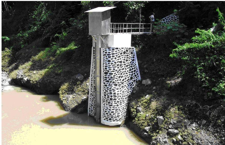
**Gambar A.14 - Pos duga air tipe konsol dengan jembatan**
