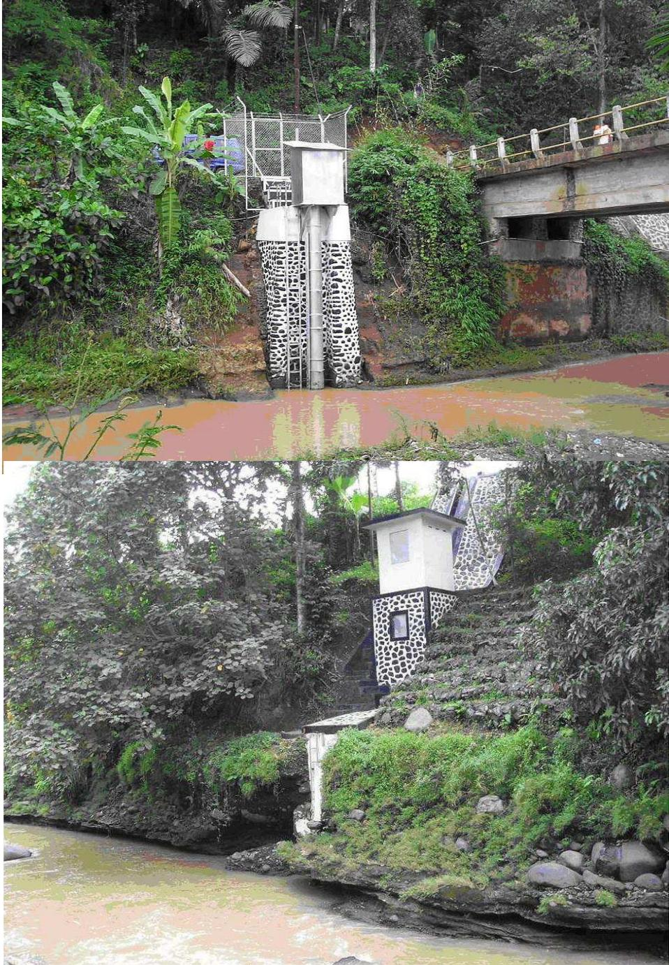
**Gambar A.16 - Contoh pos duga air tipe lain (*Flushing*)**
