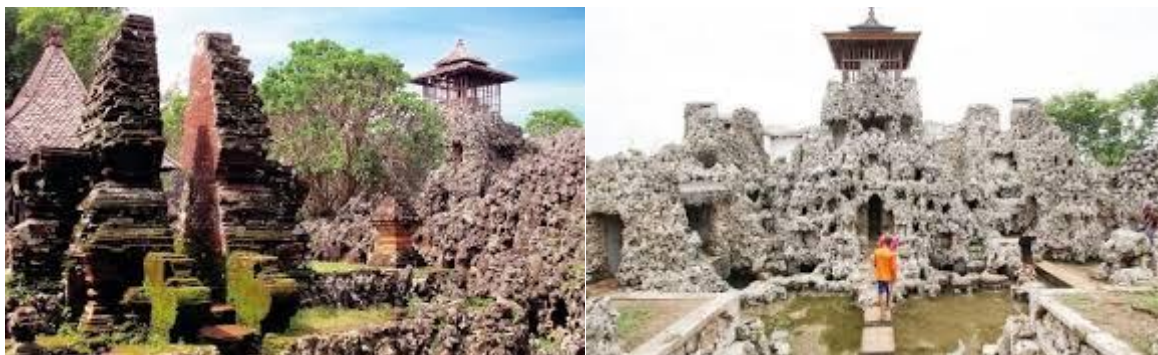
Gambar 4.14 Kondisi Objektif Wisata Taman Gua Sunyaragi
