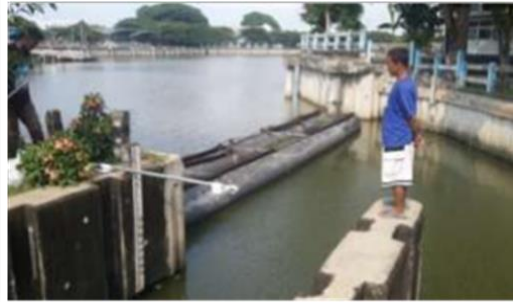
Sensor dan Tiang Penyangga
