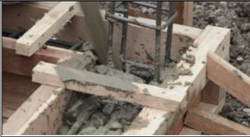
Gambar 58. Pengecoran Balok Pengikat/ Sloof
