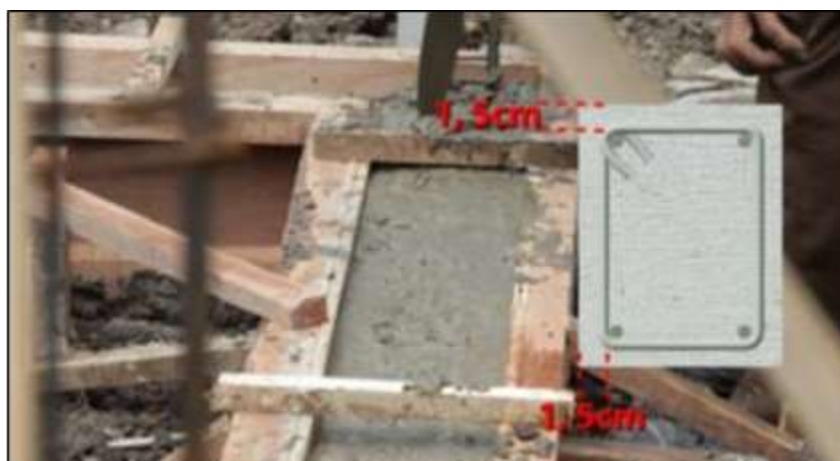
Gambar 19. Balok Pengikat/ Sloof
