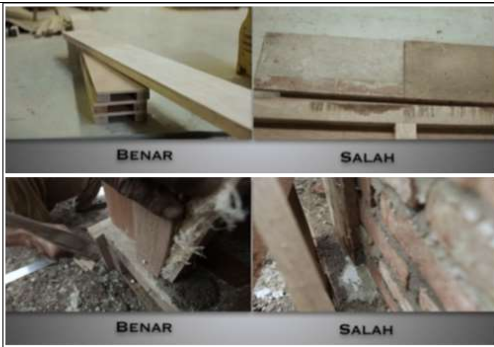
Gambar 54. Kualitas Cetakan/ Bekisting
