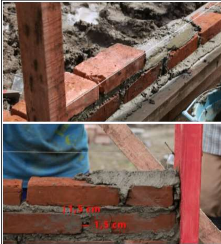
Gambar 41. Proses Pemasangan Batu Bata Untuk Dinding
