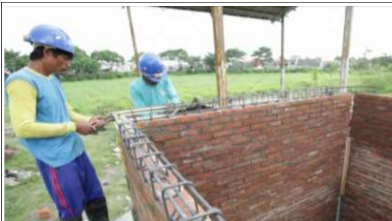
Gambar 58. Pengecoran Balok Pengikat/ Sloof
