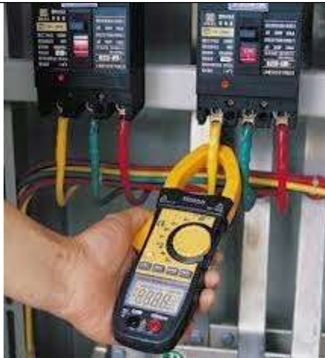
Ilustrasi Pemeriksaan menggunakan Clamp Meter
