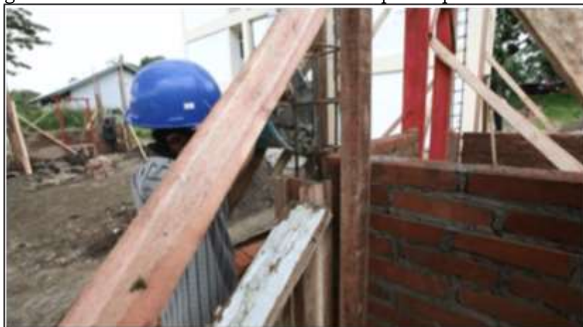
Gambar 56. Proses Pengecoran Kolom
