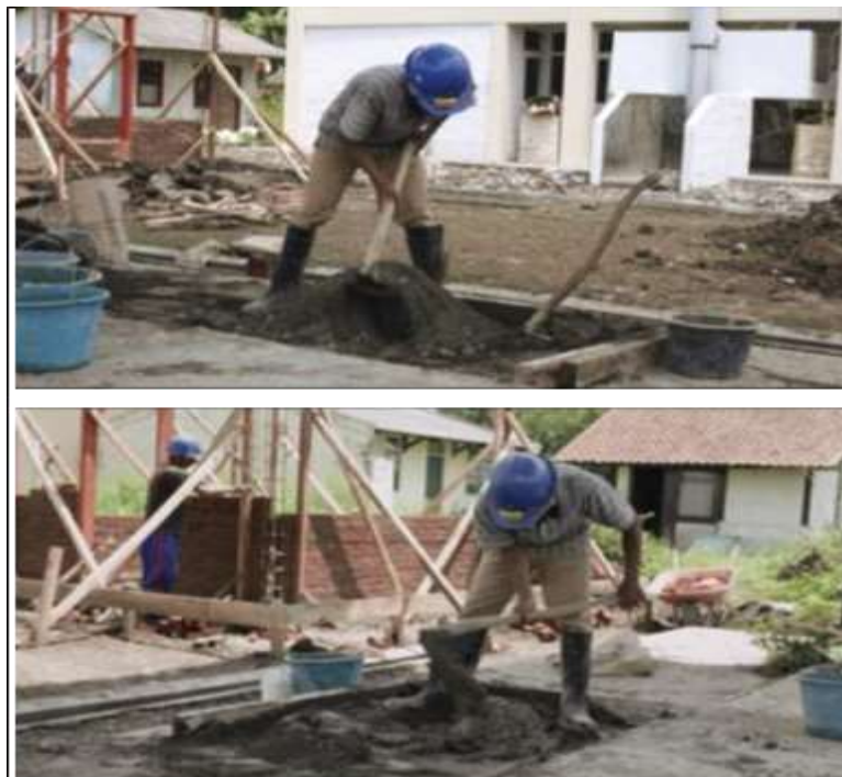
Gambar 8. Proses Pencampuran Mortar
