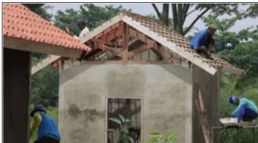
Gambar 27. Kuda-kuda Kayu Pada Atap Rumah Tinggal
