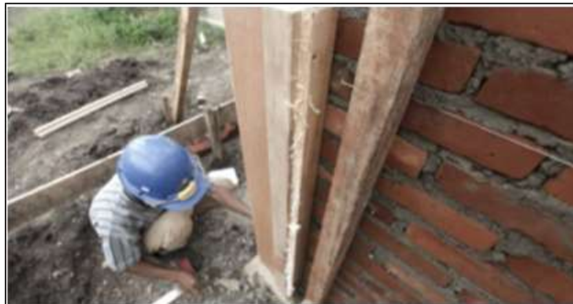
Gambar 55. Pemasangan Cetakan/ Bekisting Untuk Kolom
