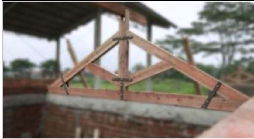
Gambar 28. Kuda-kuda Kayu Dengan Pengikat Plat Baja
