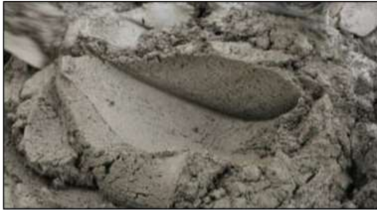
Gambar 9. Hasil Pencampuran Mortar Yang Baik
