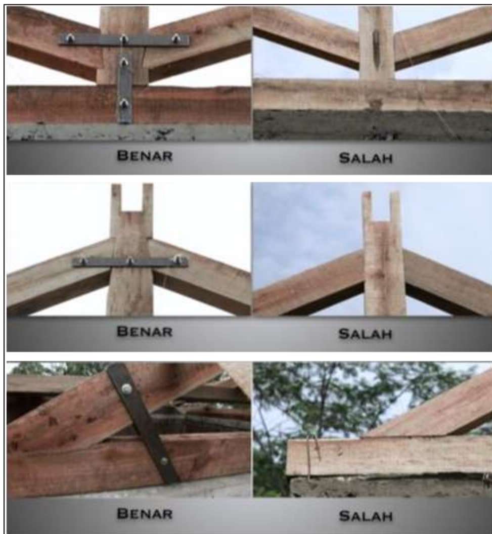
Gambar 29. Pemasangan Plat Baja Pada Kuda-kuda Kayu
