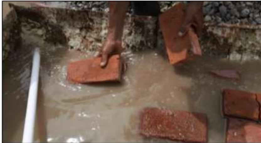
Gambar 15. Perendaman Batu Bata Sebelum Dipasang
