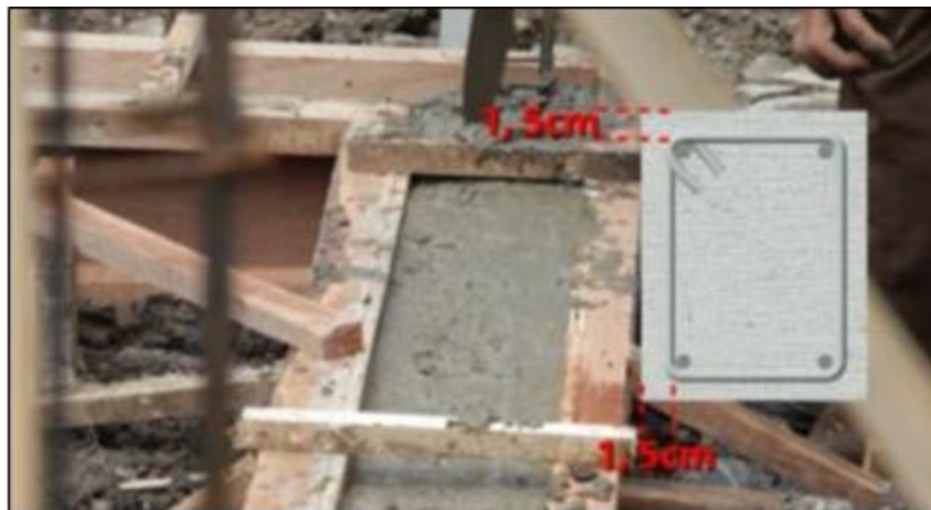
Gambar 19. Balok Pengikat/ Sloof
