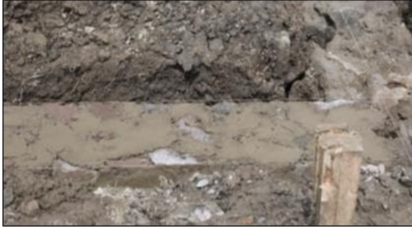
Gambar 11. Pondasi Dari Batu Kali/Gunung
