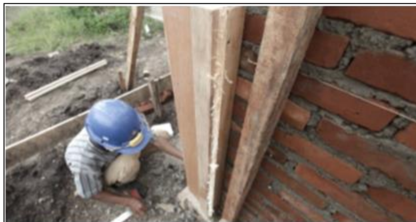
Gambar 55. Pemasangan Cetakan/ Bekisting Untuk Kolom
