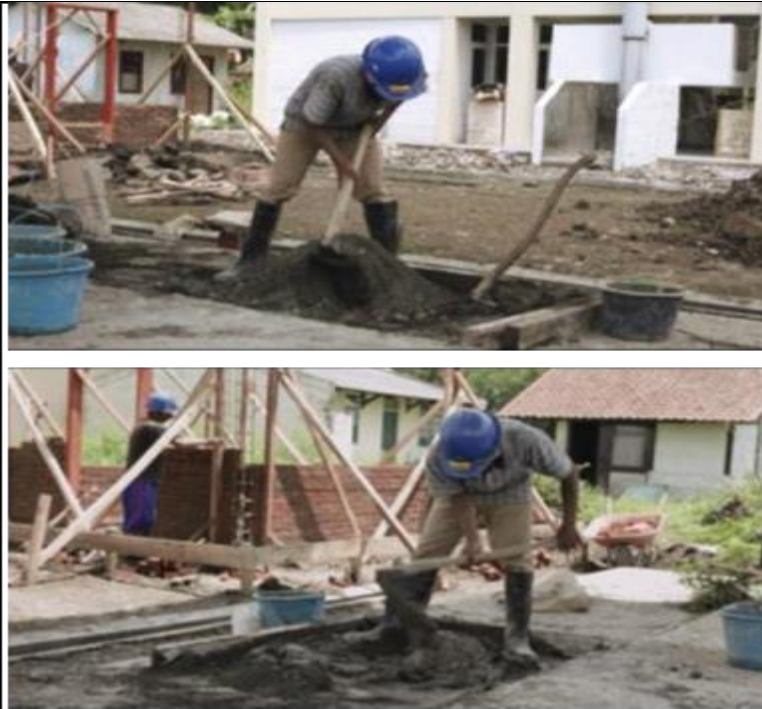
Gambar 8. Proses Pencampuran Mortar
