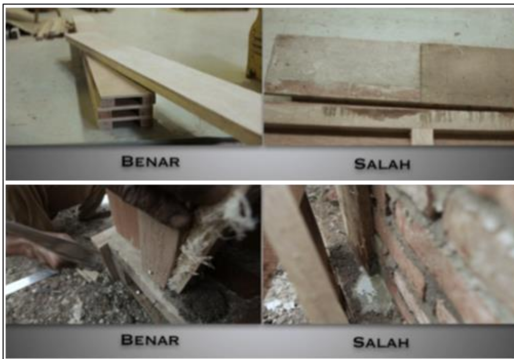
Gambar 54. Kualitas Cetakan/ Bekisting
