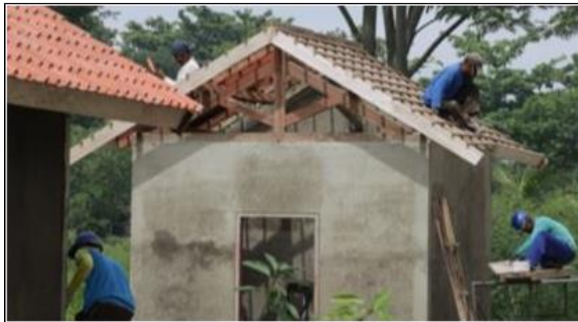
Gambar 27. Kuda-kuda Kayu Pada Atap Rumah Tinggal
