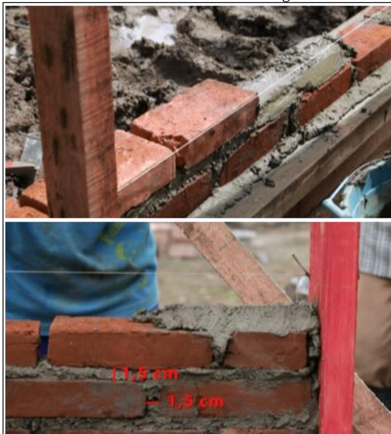
Gambar 41. Proses Pemasangan Batu Bata Untuk Dinding
