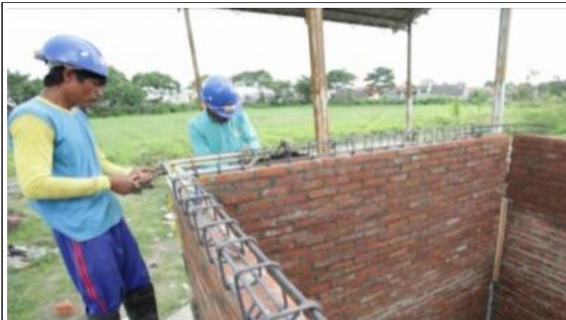
Gambar 58. Pengecoran Balok Pengikat/ Sloof
