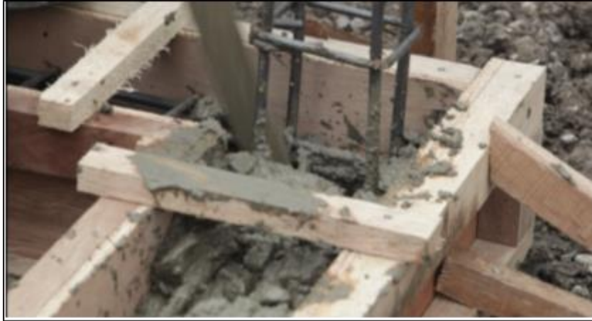
Gambar 58. Pengecoran Balok Pengikat/ Sloof
