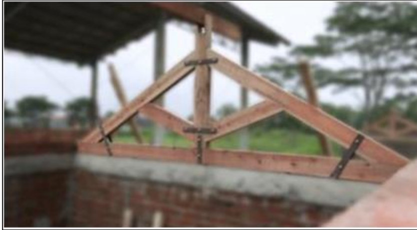
Gambar 28. Kuda-kuda Kayu Dengan Pengikat Plat Baja
